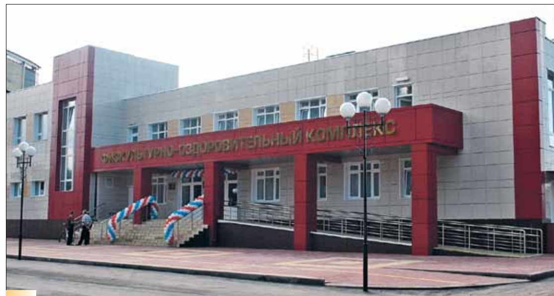
Физкультурно-оздоровительный комплекс (ФОК) с плавательным бассейном в пгт Анна Воронежской обл. введен в эксплуатацию 31.08.2012г., с опережением на 3 месяца
