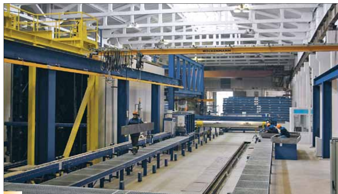
Запуск новой технологической линии по выпуску ЖБИ на заводе крупнопанельного домостроения
