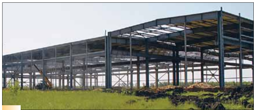
Строительство завода металлических конструкций
