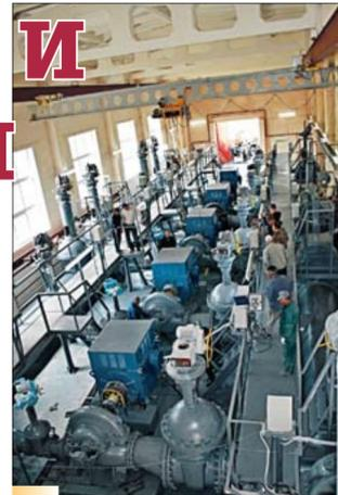
Водозабор на намывном острове ВПС-4 в г. Воронеже. В проект водозабора входят 34 эксплуатационные скважины, насосная станция производительностью 120 тыс. кубов в сутки, два резервуара мощностью по 5 тыс. куб.м в сутки, а также технологическая эстакада, соединяющая намывной остров с материковой частью. С 1 декабря 2011 года обновленная ВПС-4 успешно обеспечивает круглосуточное водоснабжение жителей Воронежа.
